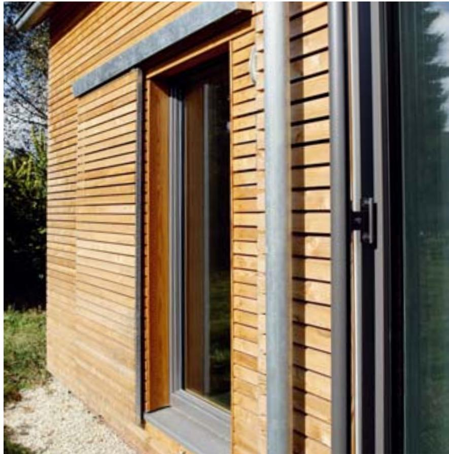
Oben und links: die Fassade besteht aus unbehandelten Lärche-Trapezeisten
